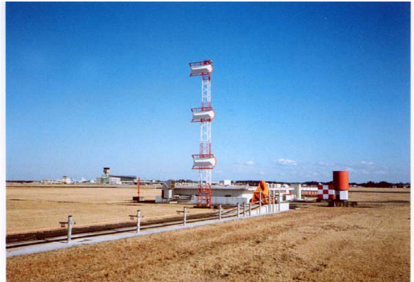
● ILS · VOR/TAC Training Site Building
